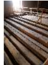
Ell.II, Dachstuhl, DI023090, BSV-
