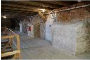
Ell.II, Dachstuhl, DI023075, BSV-
