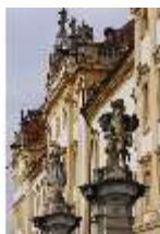
Ell.I, Südfassade, DI023032, BSV-
