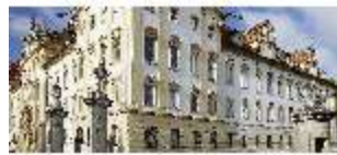
Ell.I, Fassade Stadtseite, DI015365, BSV-
