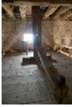
Ell.II, Dachstuhl, DI023063, BSV-
