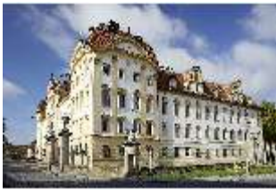
Ell.I, Fassade Stadtseite, DI015363, BSV-
