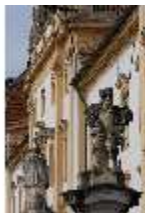
Ell.I, Südfassade, DI023028, BSV-
