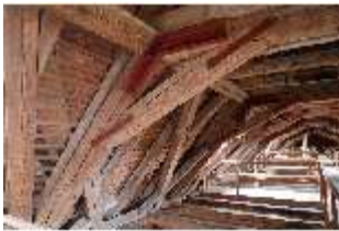
Ell.II, Dachstuhl, DI023044, BSV-
