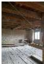
Ell.II, Dachstuhl, DI023052, BSV-
