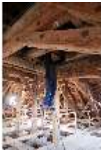
Ell.II, Dachstuhl, DI023156, BSV-
