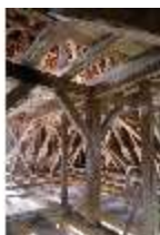
Ell.II, Dachstuhl, DI023060, BSV-
