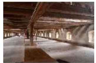
Ell.II, Dachstuhl, DI023035, BSV-
