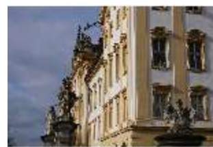
Ell.I, Südfassade und Ostflügel, DI023026, BSV-
