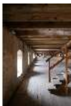
Ell.II, Dachstuhl, DI023037, BSV-
