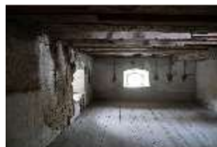
Ell.II, Dachstuhl, DI023166, BSV-
