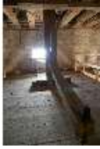
Ell.II, Dachstuhl, DI023064, BSV-
