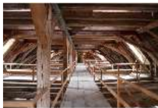
Ell.II, Dachstuhl, DI015914, BSV
