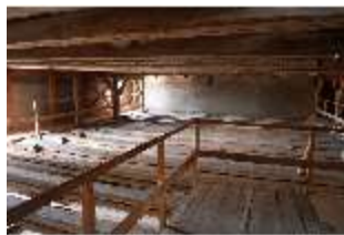
Ell.II, Dachstuhl, DI023092, BSV-
