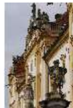
Ell.I, Südfassade, DI023029, BSV-
