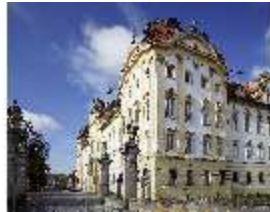
Ell.I, Fassade Stadtseite, DI015364, BSV-
