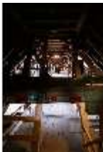
Ell.II, Dachstuhl, DI023160, BSV-
