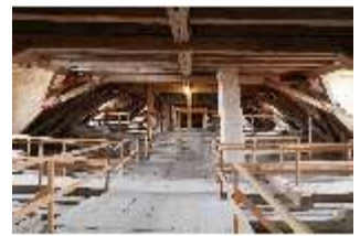
Ell.II, Dachstuhl, DI023163, BSV-
