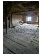
Ell.II, Dachstuhl, DI023050, BSV-
