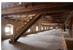
Ell.II, Dachstuhl, DI023036, BSV-
