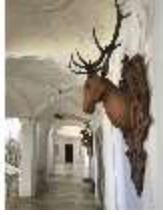
Ell.II, Treppenhaus im 2. OG, DI019583, BSV
