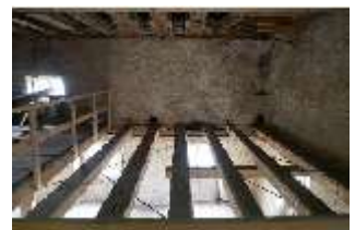
Ell.II, Dachstuhl, DI023054, BSV-
