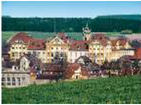
Ell.I, Ansicht der Gesamtanlage, DE003136, BSV-
