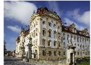
Ell.I, Fassade Stadtseite, DI015366, BSV-
