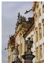
Ell.I, Südfassade, DI023027, BSV-
