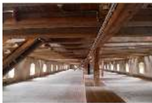
Ell.II, Dachstuhl, DI015913, BSV
