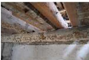
Ell.II, Dachstuhl, DI023164, BSV-
