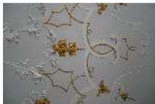
Ell.II, Festsaal, Detail der Decke, DI023079, BSV-
