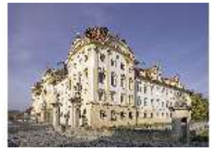
Ell.I, Fassade Stadtseite, DI015362, BSV-
