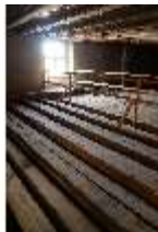
Ell.II, Dachstuhl, DI023091, BSV-
