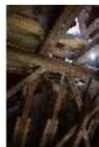
Ell.II, Dachstuhl, DI023057, BSV-
