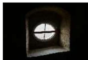
Ell.II, Dachstuhl, DI023038, BSV-
