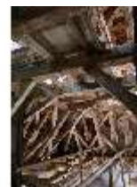
Ell.II, Dachstuhl, DI023062, BSV-
