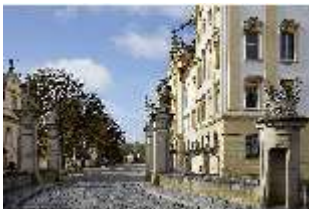
Ell.I, Fassade Stadtseite, DI015367, BSV-
