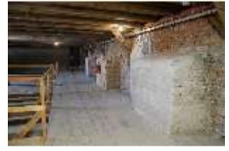
Ell.II, Dachstuhl, DI023074, BSV-
