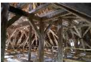
Ell.II, Dachstuhl, DI023059, BSV-
