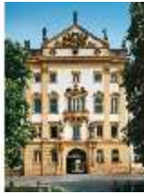
Ell.I, Mittelrisalit, Portal offen, DE001241, BSV-
