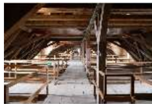
Ell.II, Dachstuhl, DI023049, BSV-
