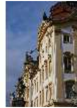
Ell.I, Südfassade, DI023025, BSV-
