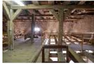
Ell.II, Dachstuhl, DI023065, BSV-
