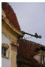
Ell.I, Südfassade mit Wasserspeier, DI023031, BSV-
