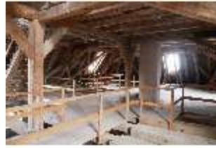
Ell.II, Dachstuhl, DI023042, BSV-
