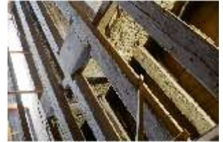
Ell.II, Dachstuhl, DI023069, BSV-
