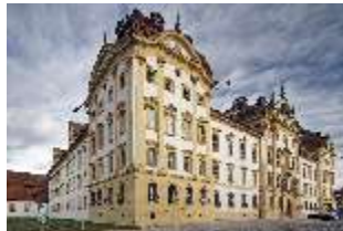
Ell.I, Fassade Stadtseite, DI015466, BSV-
