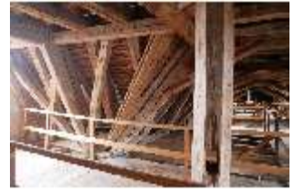
Ell.II, Dachstuhl, DI023043, BSV-
