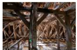
Ell.II, Dachstuhl, DI023058, BSV-
