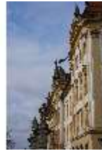
Ell.I, Südfassade, DI023024, BSV-
