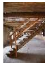
Ell.II, Dachstuhl, DI023039, BSV-
