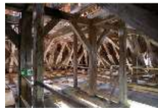
Ell.II, Dachstuhl, DI015915, BSV
