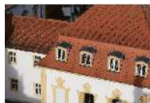
Ell.I, Blick vom Dach, Dachgeschoss, DI023142, BSV-
