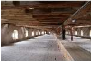
Ell.II, Dachstuhl, DI023040, BSV-
