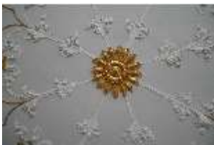
Ell.II, Festsaal, Detail der Decke, DI023078, BSV-
