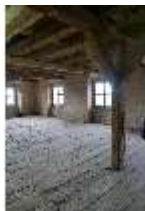
Ell.II, Dachstuhl, DI023051, BSV-
