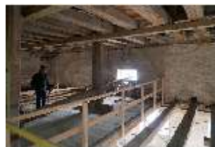
Ell.II, Dachstuhl, DI023053, BSV-
