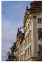
Ell.I, Südfassade, DI023023, BSV-
