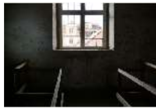
Ell.II, Dachstuhl, DI023162, BSV-
