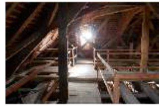
Ell.II, Dachstuhl, DI023155, BSV-
