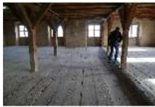
Ell.II, Dachstuhl, DI023157, BSV-
