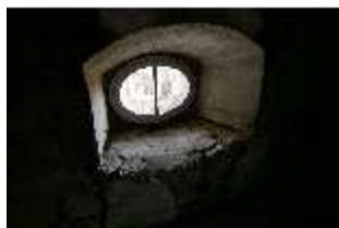
Ell.II, Dachstuhl, DI023165, BSV-
