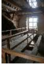
Ell.II, Dachstuhl, DI023041, BSV-
