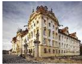
Ell.I, Fassade der Stadtseite, DI015472, BSV-
