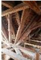
Ell.II, Dachstuhl, DI023045, BSV-
